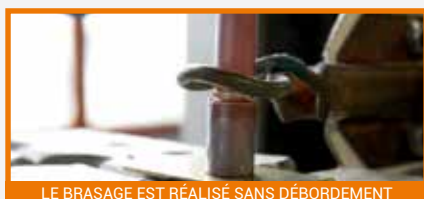
LE BRASAGE EST RÉALISÉ SANS DÉBORDEMENT
